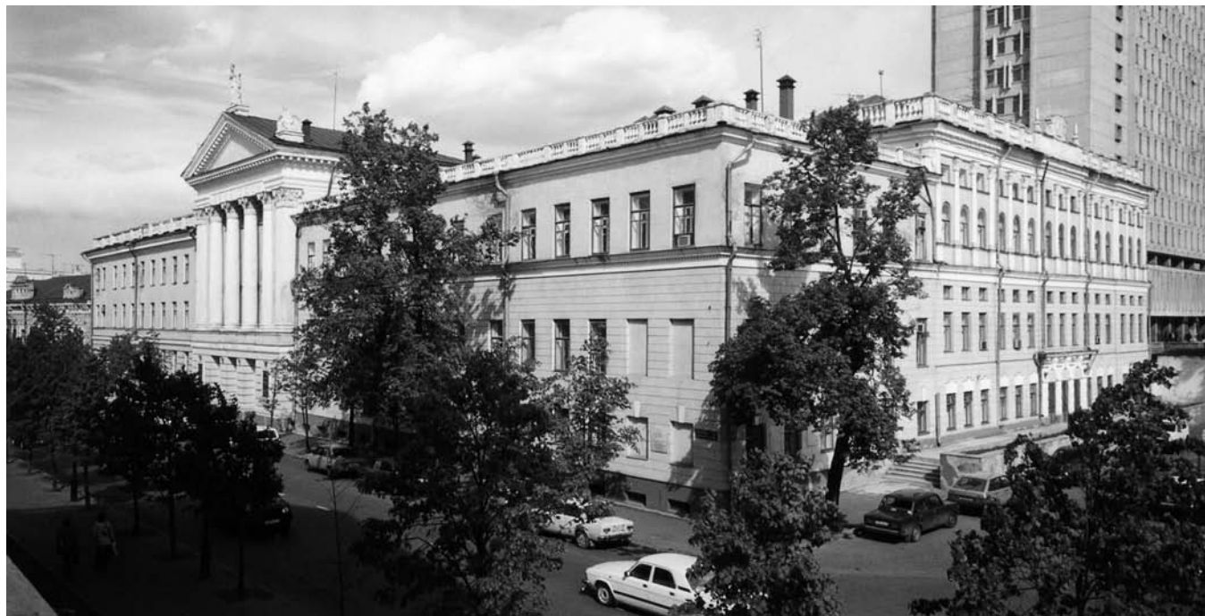
Здание Казанского научного центра Российской академии наук по ул. Лобачевского, 2/31, где расположена часть научно-производственных и хозяйственных подразделений КФТИ им. Е. К. Завойского (фото автора).
